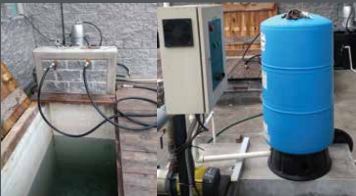
INSTALACIÓN HIDRÁULICA PARA PRUEBA DE PRESIÓN
